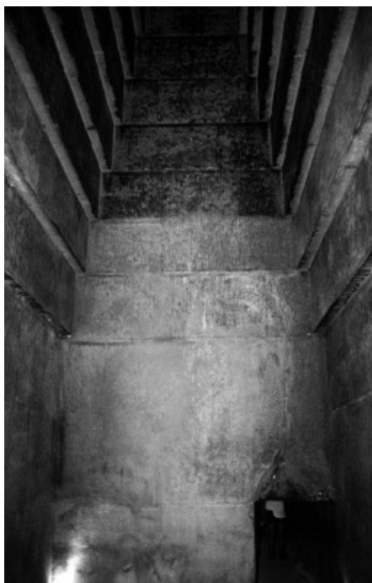
Bóveda en saledizo del interior de la Pirámide Roja de Dashur. Fotografía de Nacho Ares.
